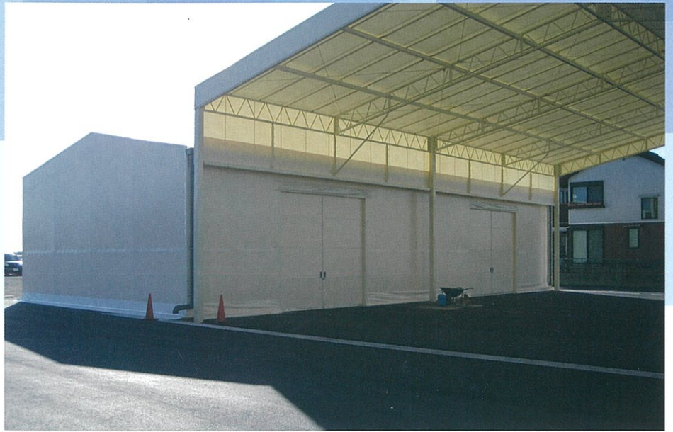
テント倉庫W10×L21×H4.5m+荷捌場テントW16×L21×H6m
