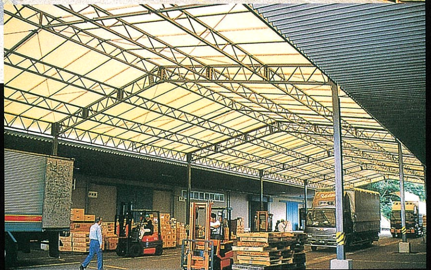
倉庫業荷捌場内部
