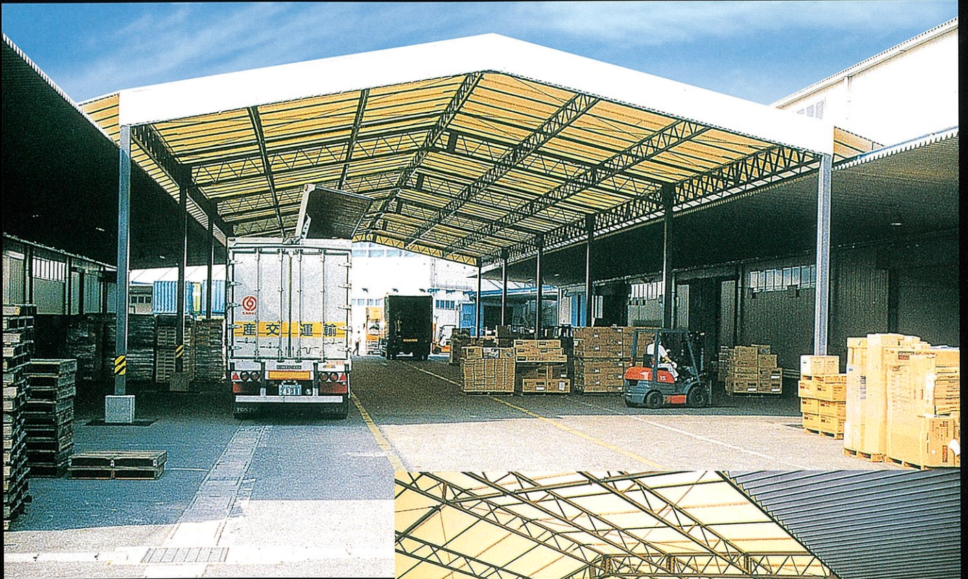
倉庫業荷捌場 ●W14×L46×H5 (m)
